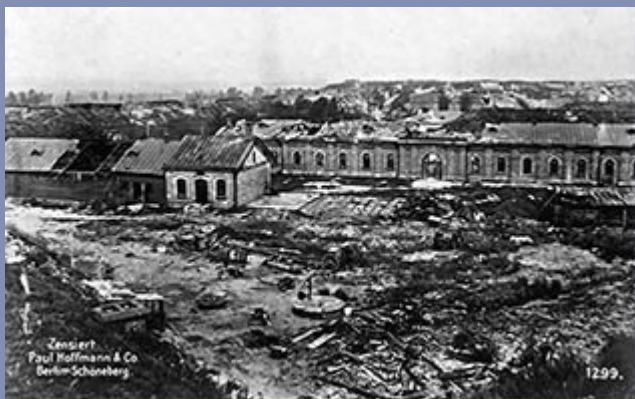
Zniszczenia w północnej części twierdzy Osowiec (1915 r.).
