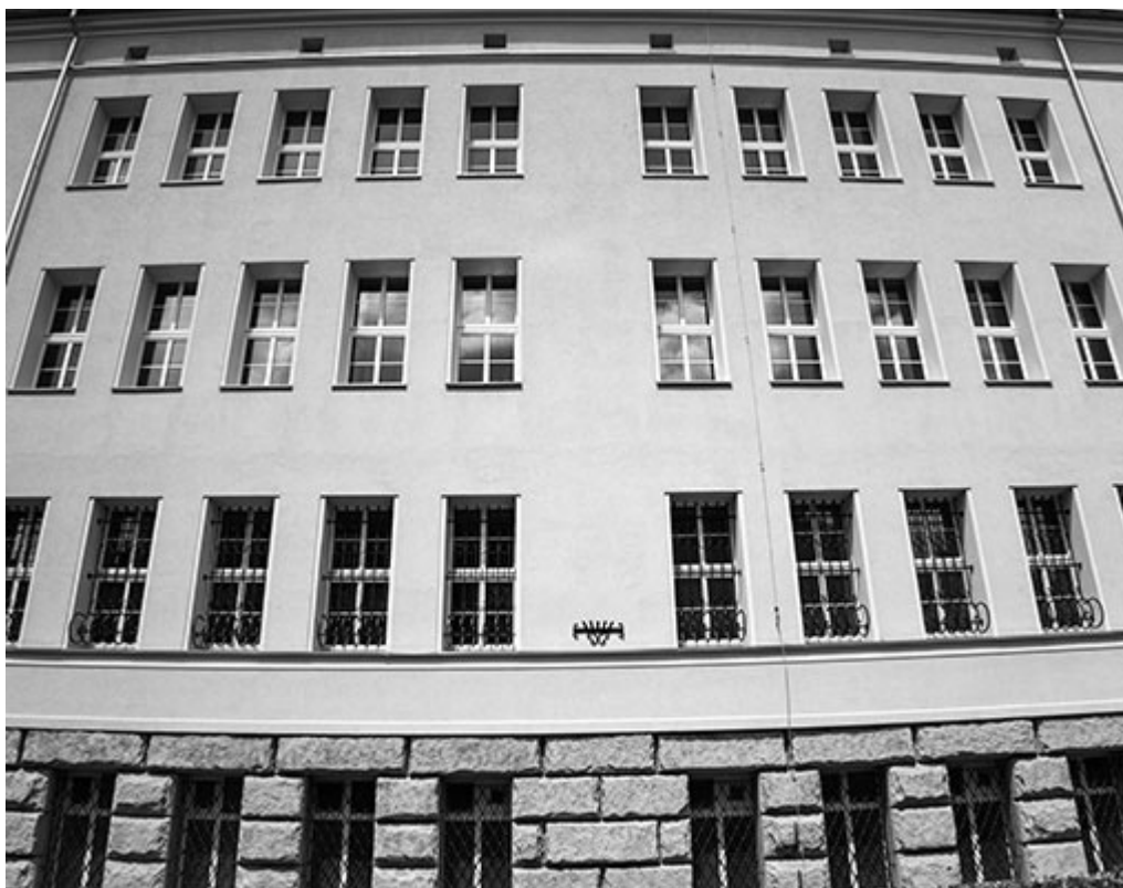
Budynek główny kurii biskupiej i Wyższego Seminarium Duchownego. Zakratowane okna powyżej sutereny to główna aula seminarium, a piętro wyżej znajdują się okna refektarza.
